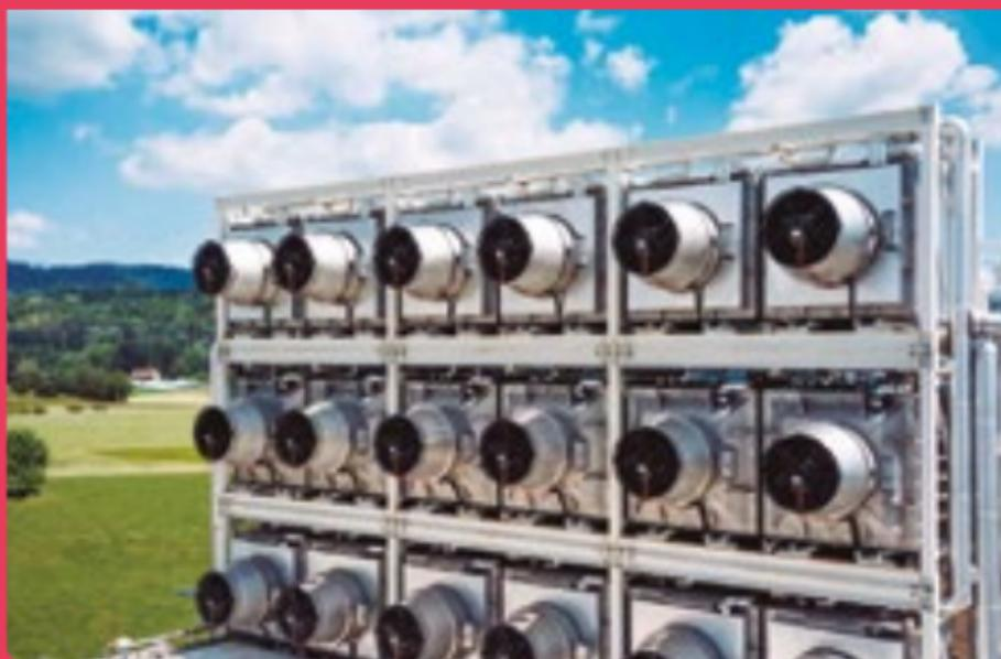
Estos sistemas utilizan procesos químicos para capturar y separar el CO<sub>2</sub> del aire mediante ventiladores y filtros. El CO<sub>2</sub> capturado se almacena después bajo tierra.
